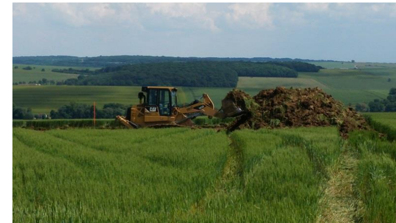
Photographie 8. Retrait de la terre végétale
