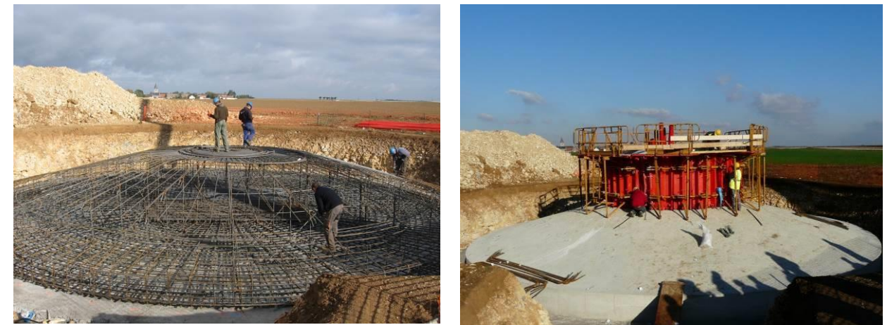
Photographie 6. Ferrailage et mise en œuvre des fondations
