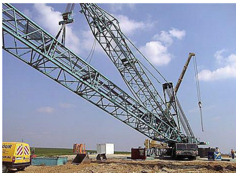
Photographie 7. Grue de levage sur une plateforme
