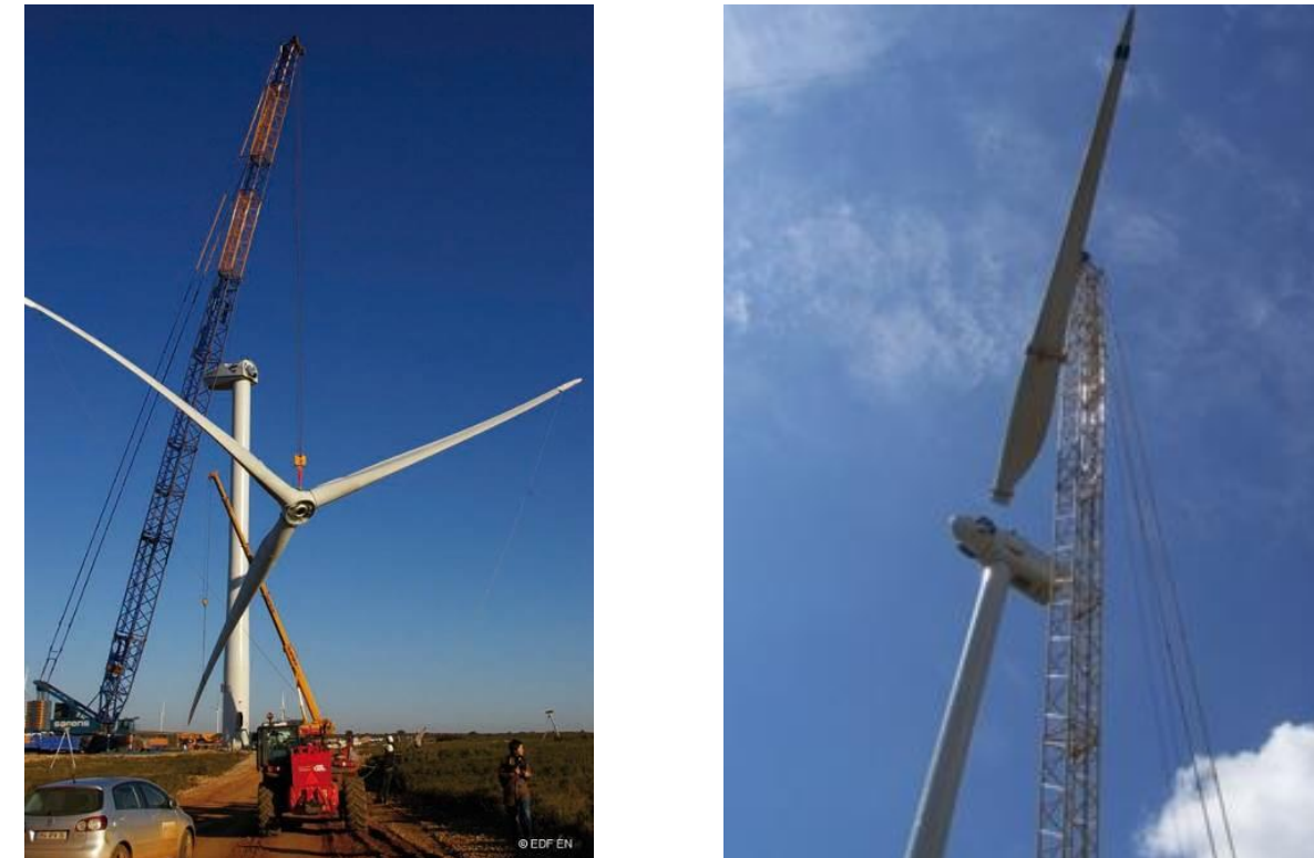
Photographie 13. Montage de l'hélice et montage « pale par pale »
