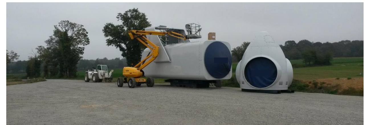
Photographie 11. Stockage des éléments au sol
