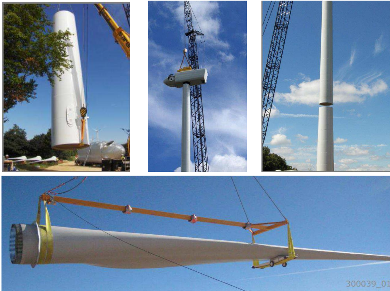
Photographie 12. Montage et assemblage des éoliennes
