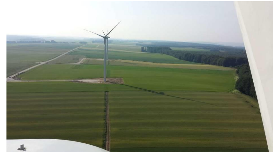
Photographie 4. Le parc éolien d'Ardouval vu depuis le toit de l'éolienne E1
