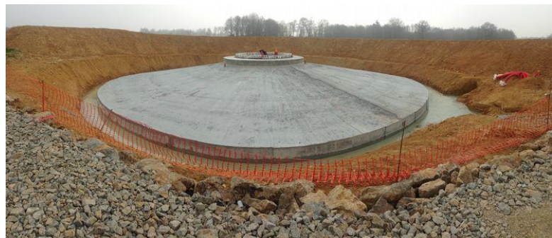
Photographie 10. Les étapes de la construction des fondations (fouille, ferrailage, séchage)
