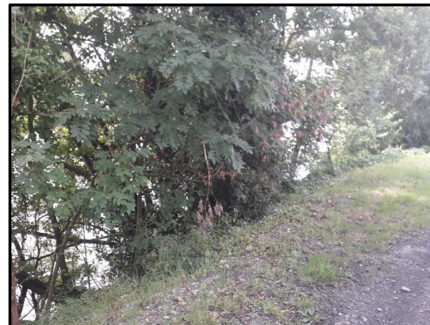
Photo 9 : Ripisylve dégradée (Rainette, 2021)
