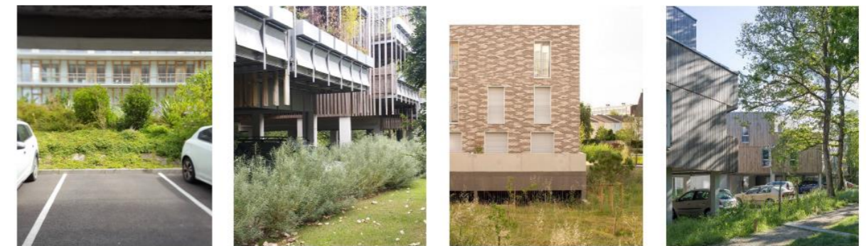
Figure 21 : Illustration du principe de transparence hydraulique (Source : COPIL, 2022)
