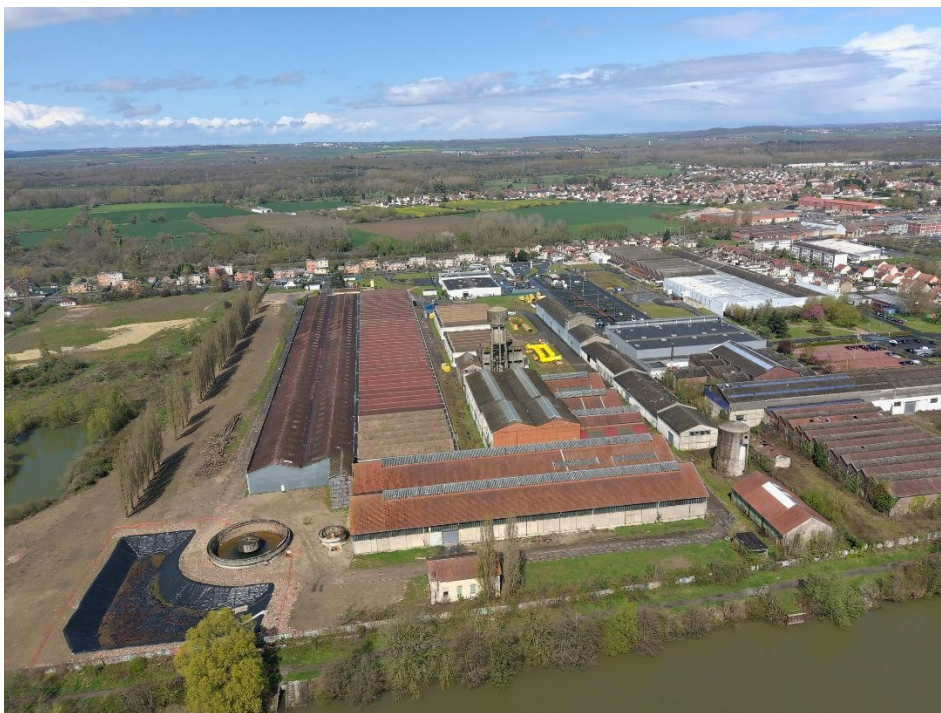
Site avec bâtiments anciennement exploités par TERBIS en cours de démolition
