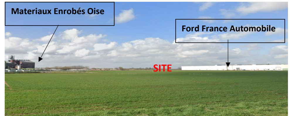
Vue du site (Sud-Est)
